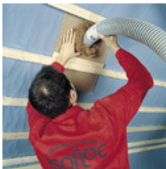
Figuur 5.3: Inblazen cellulose
