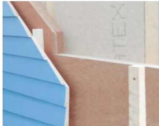
Figuur 6.1: Bevestiging regels voor gevelafwerking
