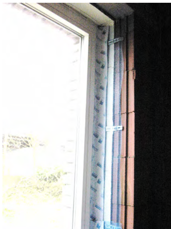
Foto 3: Bevestiging van raam mbv ankers
