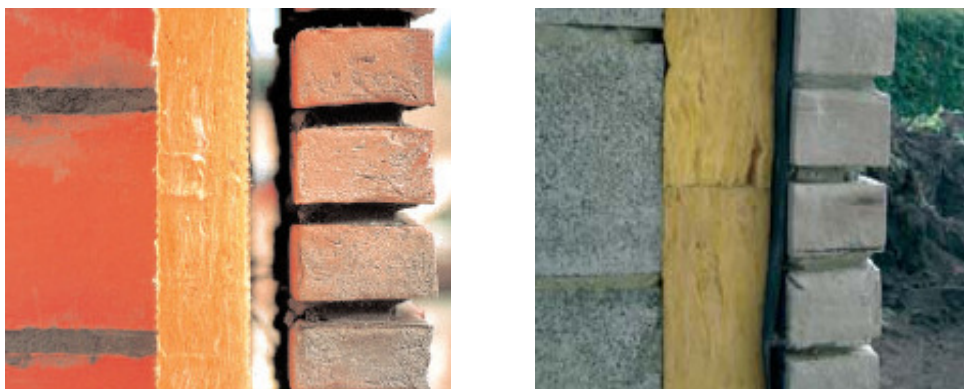
Figuur 5.4: Gedeeltelijke spouwvulling (links) en volledige spouwvulling (rechts)
