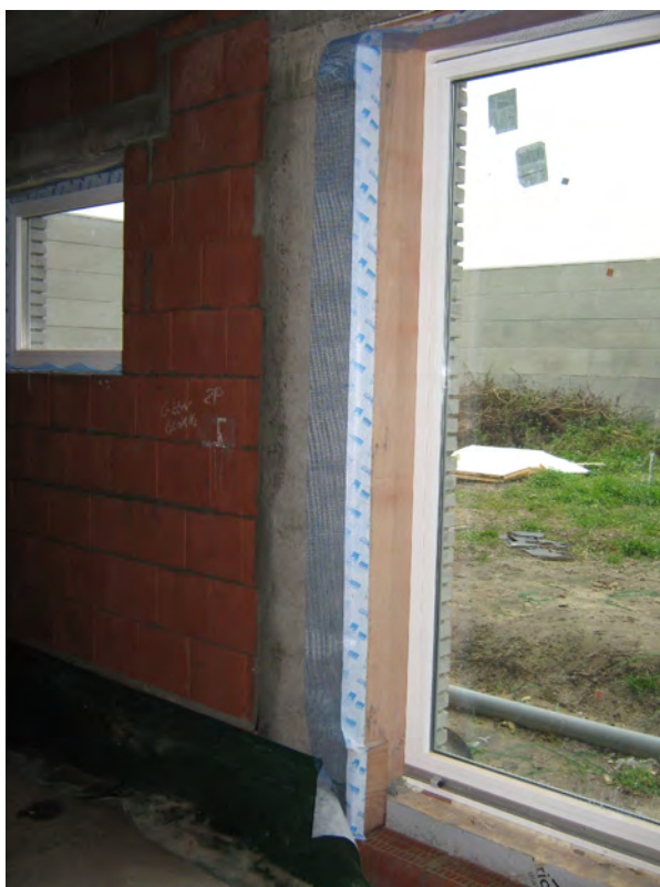
Foto 2: Bevestiging van raam mbv multiplex kader
